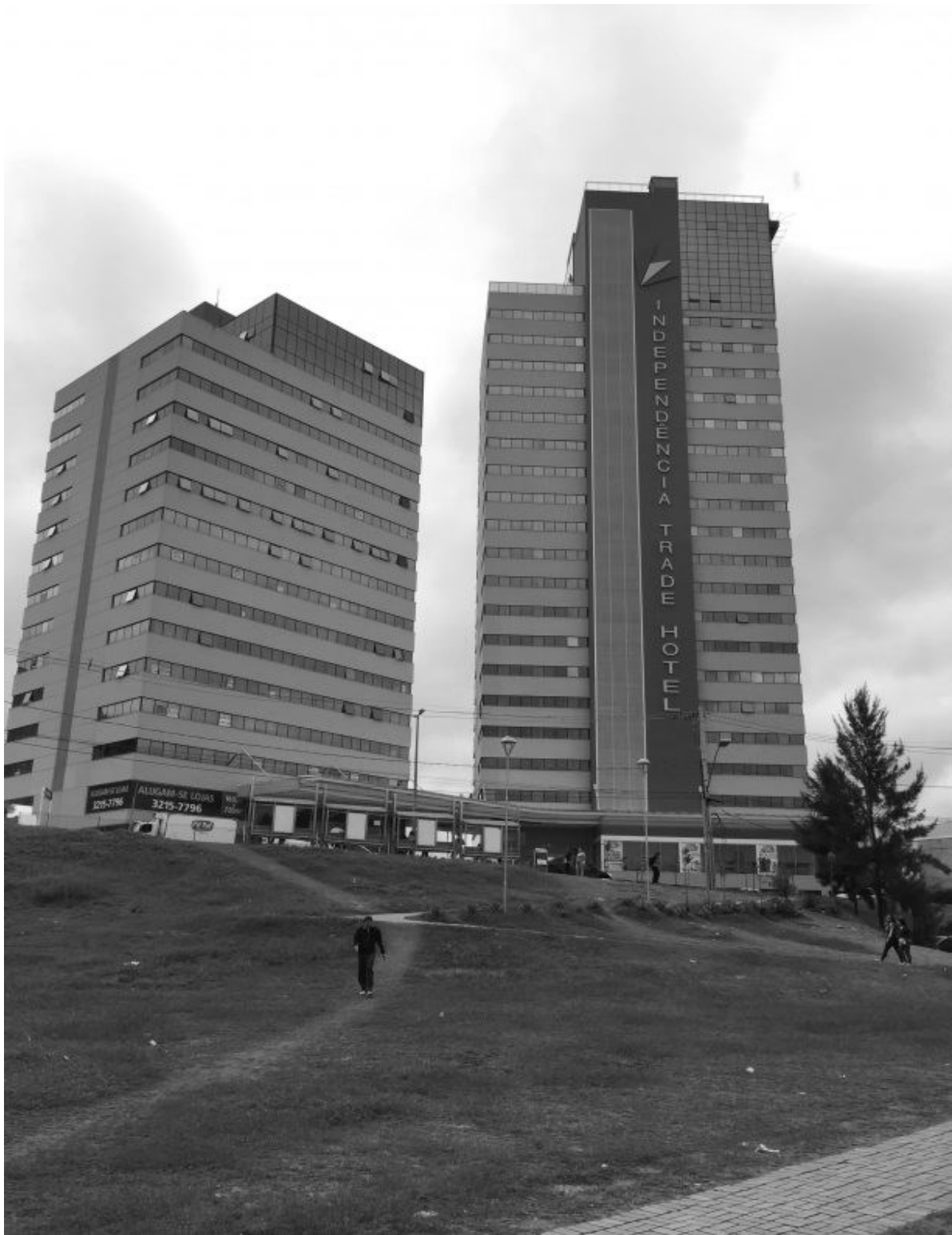
Figura 22: Torres construídas na área da Operação Urbana do IS Fonte: Confiança, sem data 14
