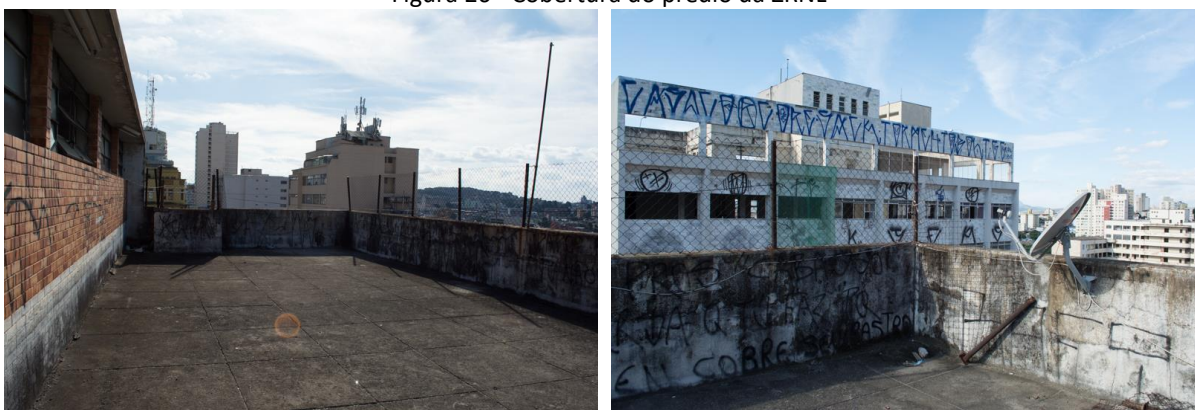
Figura 26 - Cobertura do prédio da ZRNL
