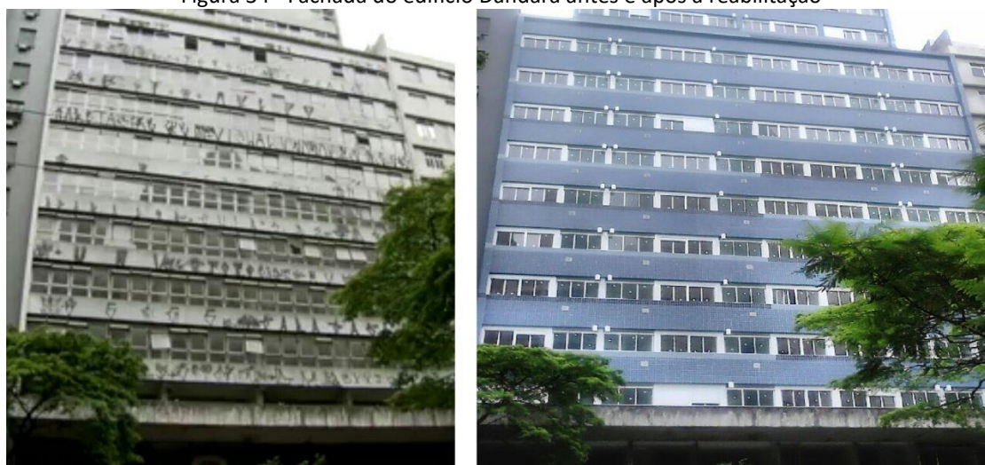
Figura 34 - Fachada do edifício Dandara antes e após a reabilitação
