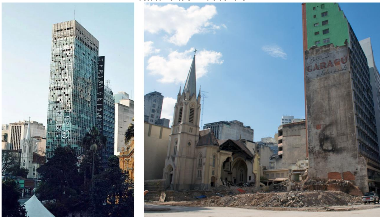
Figura 1 – Área do edifício Wilton Paes de Almeida (a) registro da ocupação em julho de 2016; (b) destroços do desabamento em maio de 2018
