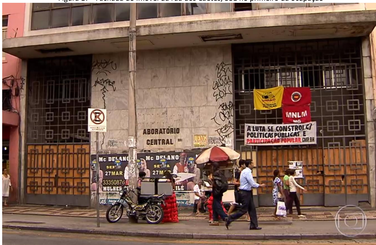
Figura 17 - Fachada do imóvel da rua dos Caetés, 331 no primeiro da ocupação
