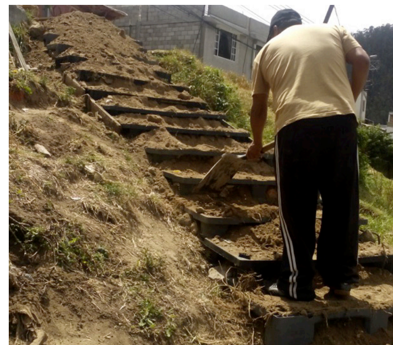
Img. 7 Mejoría de los accesos al parque por medio de una escalera de pallets plasticos
