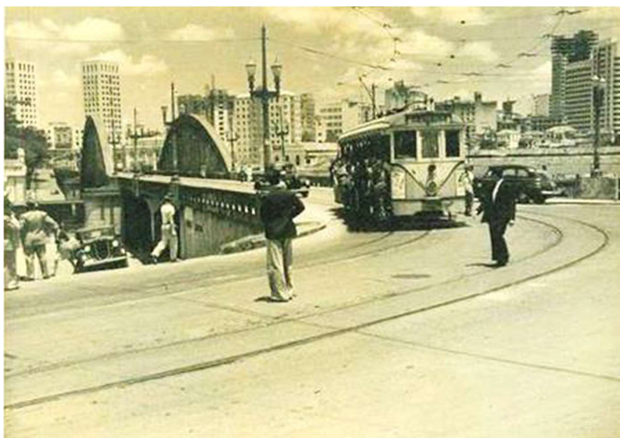
Figura 19 - Bonde atravessando o Viaduto Santa Tereza em direção à Rua Itambé, 1945
