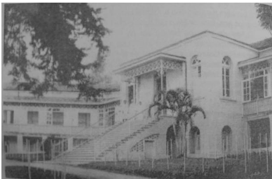
Figura 14 - Hospital do Isolado, década de 1940
