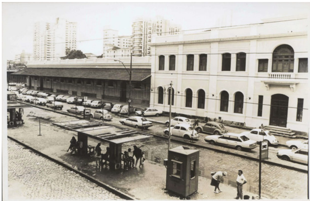
FIG. 1: Vista da Rua Aarão Reis, entre a Praça da Estação e o Viaduto Santa Tereza, sendo utilizada como estacionamento.
